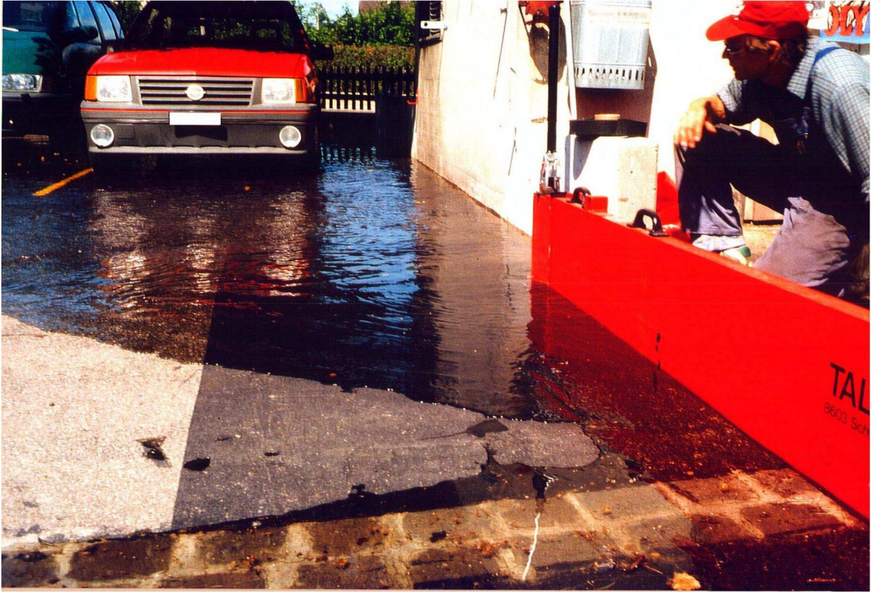
▲ Barrière anti-inondation manuelle. Serrage manuel par vérin aux extrémités. ▼
